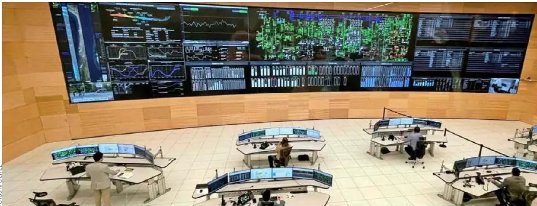
El video wall está formado por 75 pantallas de retroproyección de 70".
