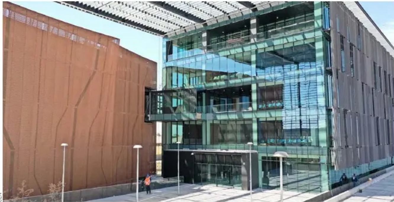
Nuevo edificio corporativo y el Centro de Despacho Nacional de Energía (CDC).
